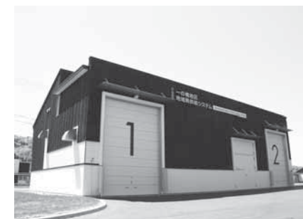
下川町の地域熱供給施設(一の橋)
