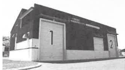
下川町の地域熱供給施設(一の橋)
