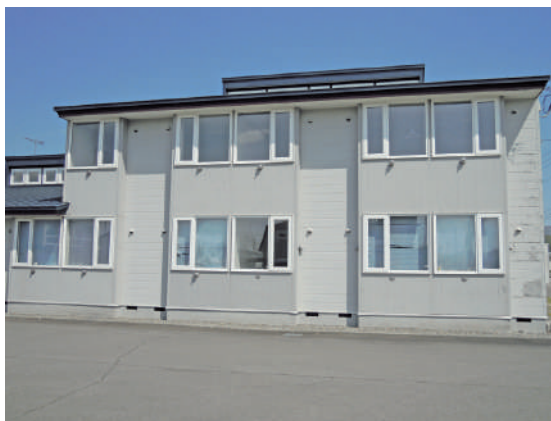
サッシの取替修繕を行うアイキャンハウス
