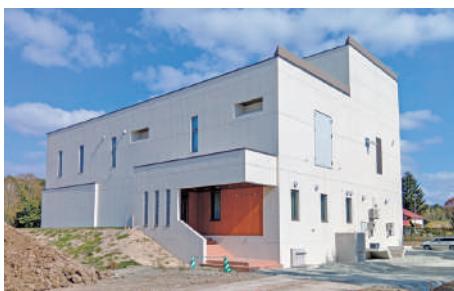
稼働を始めた下川浄水場
