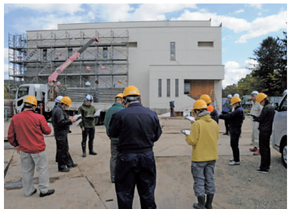
下川浄水場建設現場
