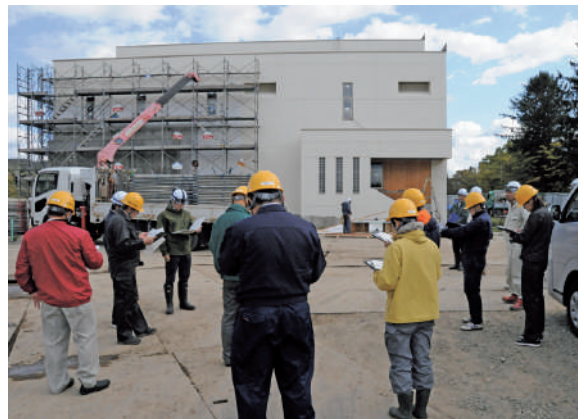
下川浄水場建設現場
