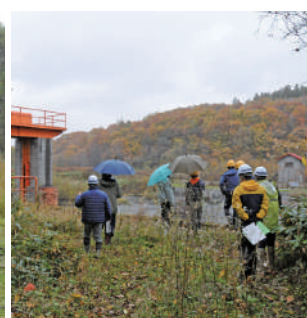
流雪溝取水口
