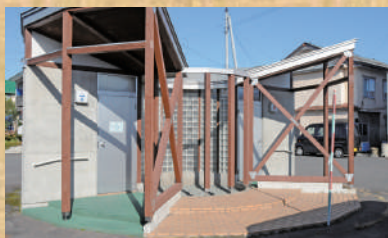
錦町公衆トイレ
