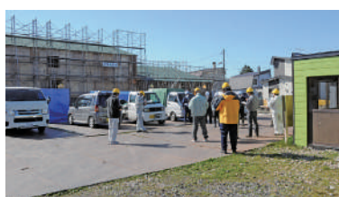
元町団地建設現場
