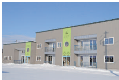
議案第26号で審議した建設中の元町団地
