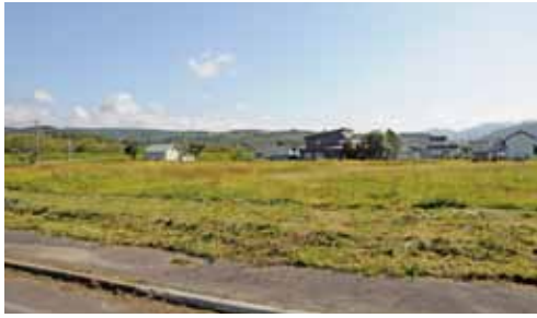
木質原料製造施設北側にある町有地に原木保管場所を整備
