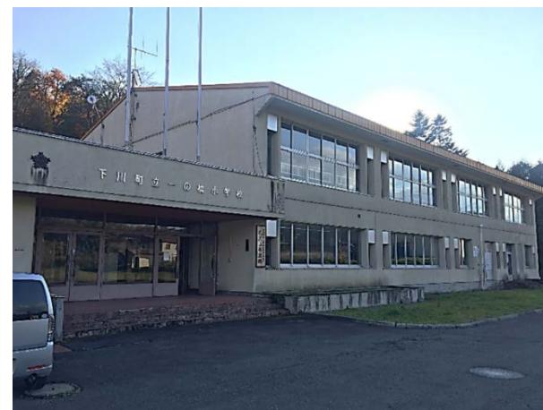
旧一の橋小学校
