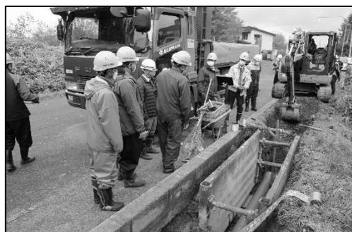
送水管に関しては、総延長は約2kmであり、本年度と来年度の単年度発注で工事が施工されるものである。埋設管は、200mm(直径)のダクタイル鋳鉄管GX型であり、埋設深度は約1.5m、施工は調査時点では、1,450mが完了していたものである。
