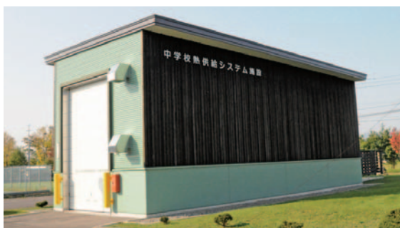
「ヨックル」の暖房用にも熱供給するボイラ施設
