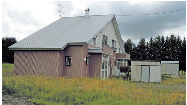
除却予定の教員住宅 木造二階建1棟2戸
