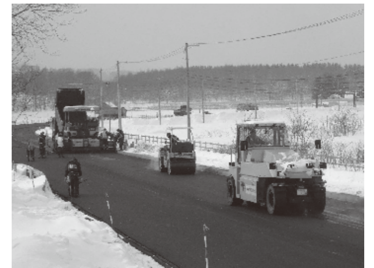
一般国道239号 下川町 上名寄道路舗装工事-1
