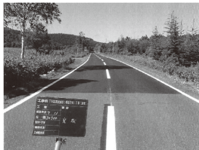
下川雄武線舗装(構造改良)工事(道債)
