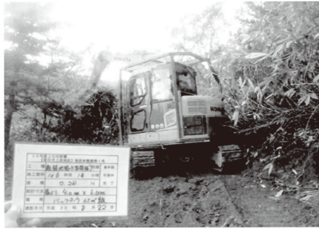
【落合沢上流地区】保安林整備第1号(地拵)
