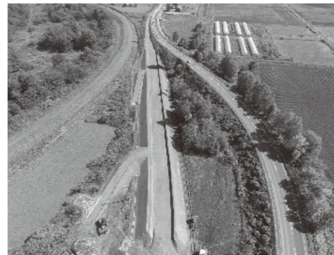
一般国道239号 下川町 上名寄改良工事-1
