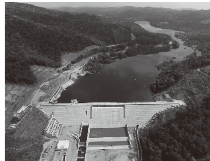
天塩川サンルダム建設事業の内 堤体建設第2期工事-1
