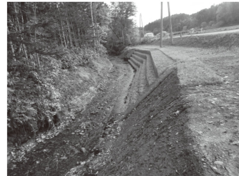
上名寄12線沢川整備工事
