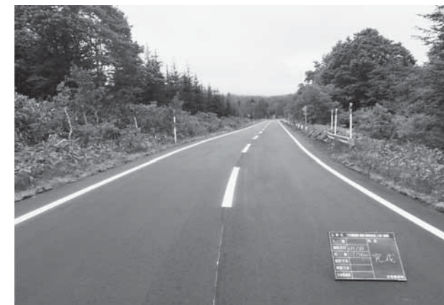
下川雄武線舗装(構造改良)工事(道債)
