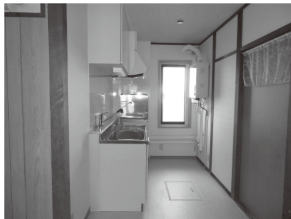
末広団地公営住宅個別改善工事
