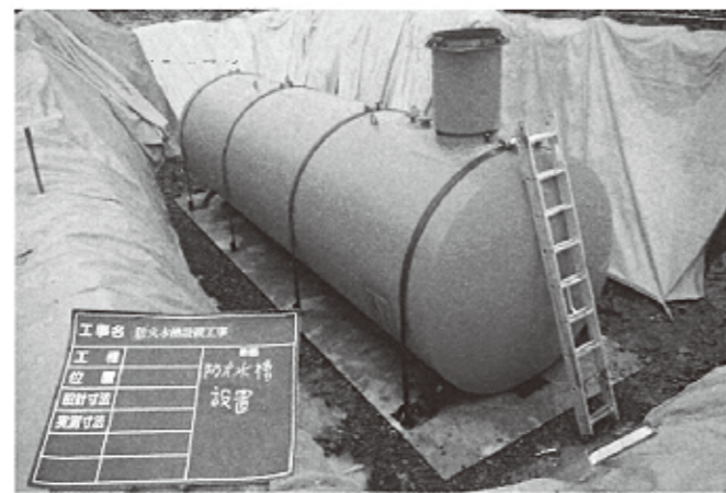
防火水槽設置工事
