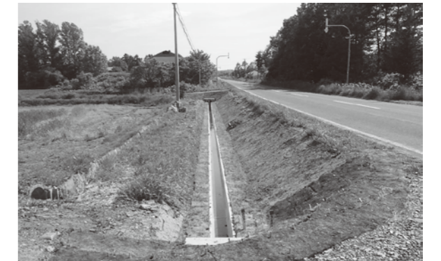
下川愛別線外局改(一般改良)工事(排水工)(道債)
