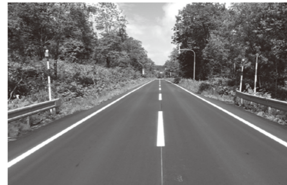
下川雄武線舗装(構造改良)工事(道債)
