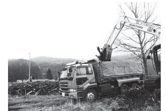
堰堤維持の内 サンルダム流木処理外工事
