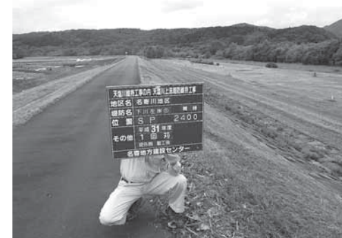
天塩川維持工事の内 天塩川上流堤防維持工事
