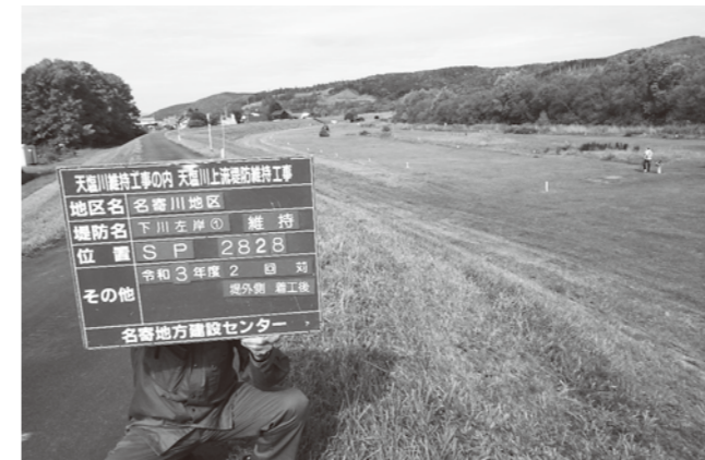
天塩川維持工事の内 天塩川上流堤防維持工事
