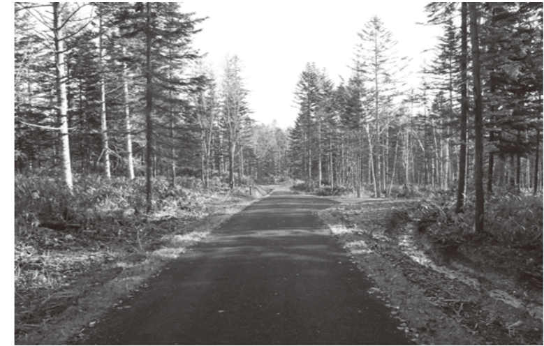
林業生産基盤整備道21世紀第3幹線開設工事
