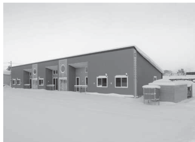
元町団地公営住宅（B棟）建設工事
