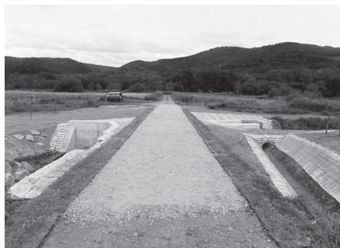
サンル13線横断管渠整備工事
