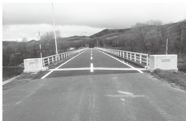
橋梁長寿命化補修工事(岐阜橋)
