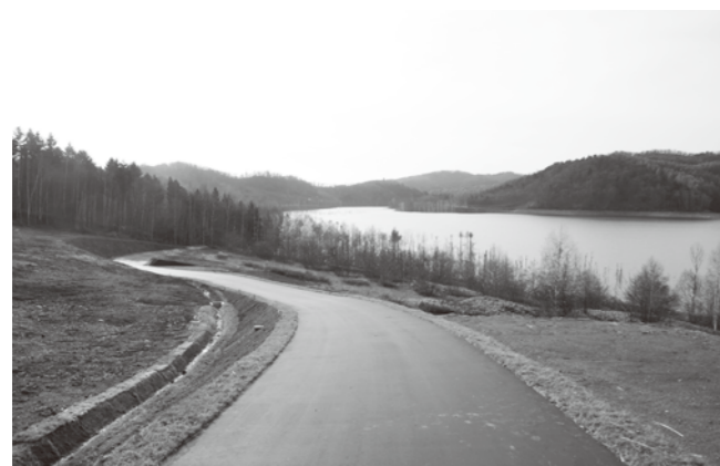
サンルダム左岸管理用道路開設工事
