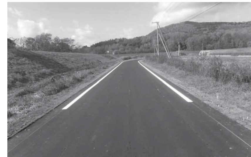
上名寄北2号線道路改良舗装工事
