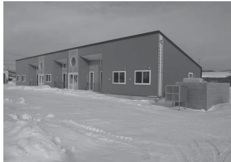
元町団地公営住宅(A棟)建設工事
