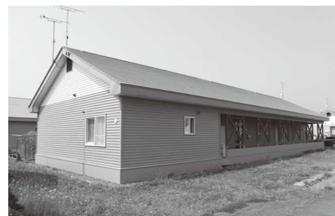
末広団地公営住宅長寿命化型改善工事
