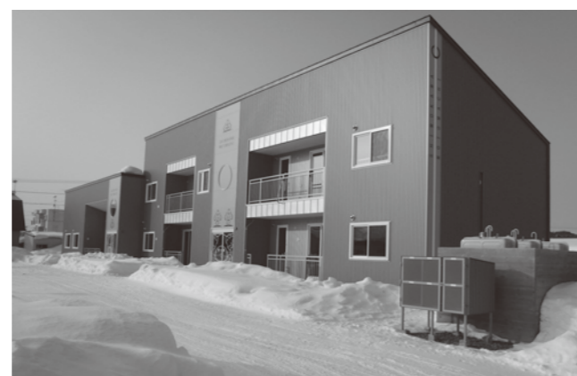
元町団地公営住宅(C棟)建設工事
