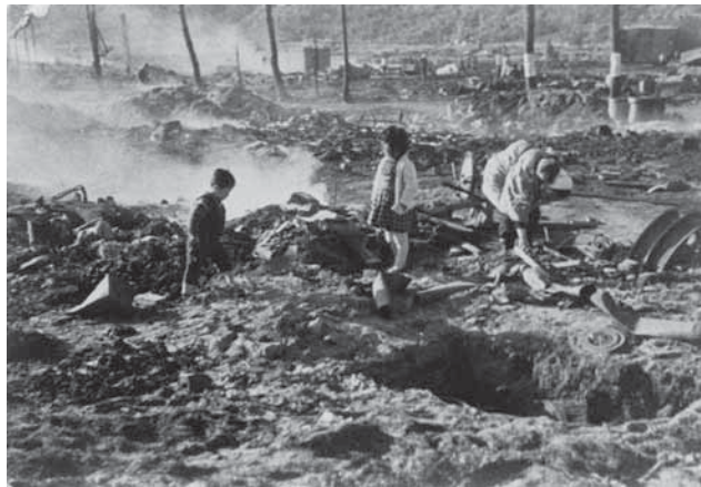
一の橋大火（昭和31年）
