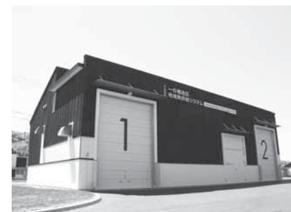
下川町の地域熱供給施設（一の橋）
