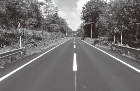
下川雄武線舗装(構造改良) 工事(道債)
