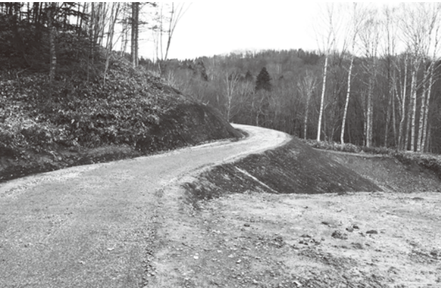
天塩川環境整備事業の内 サンルダム左岸管理用道路工事
