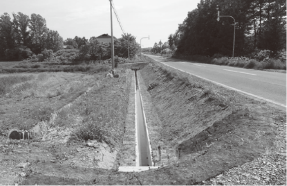
下川愛別線外局改(一般改良) 工事(排水工)(道債)
