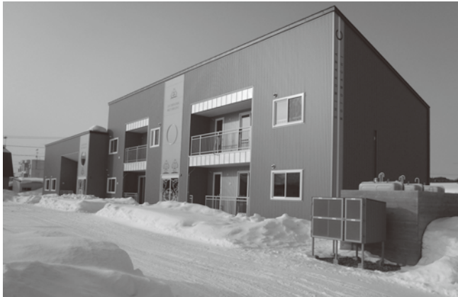
元町団地公営住宅(C棟)建設工事
