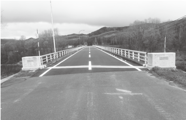
橋梁長寿命化補修工事(岐阜橋)
