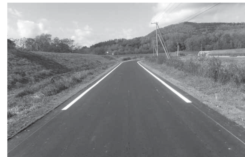
上名寄北2号線道路改良舗装工事
