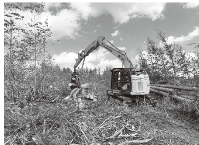
伐採作業の様子 伐採された木材は町内の製材所等で加工されます
